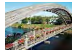
道の駅と水郷公園を結ぶ『なんだろう橋』
