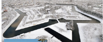
外国勢力から奉行所を守るための防衛施設(上)、外交交渉の拠点 箱館奉行所は2010年に復元(左)
